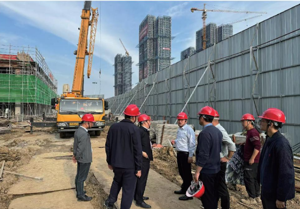
(2024年4月,肥西雲著项目现场)
